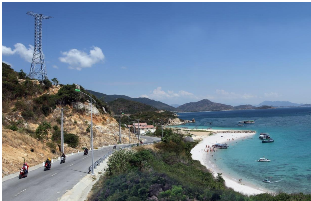
Tuyến đường ven biển đoạn qua Bình Tiên-Vĩnh Hy
